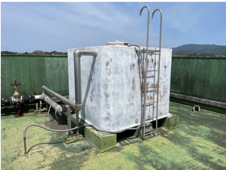
令和4年度 三股町中央公民館高架水槽取替修繕
